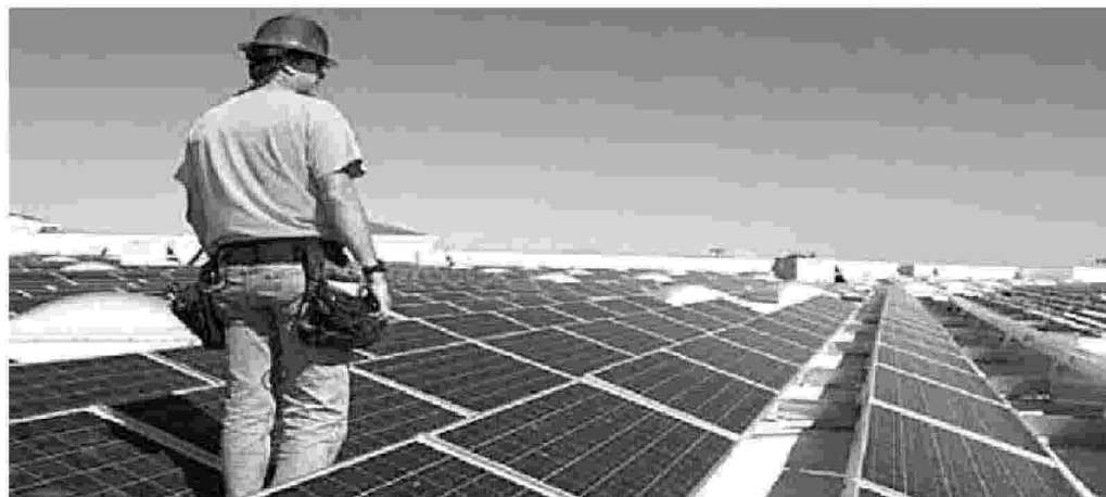
Installatore di pannelli fotovoltaici, uno dei lavori "green"
