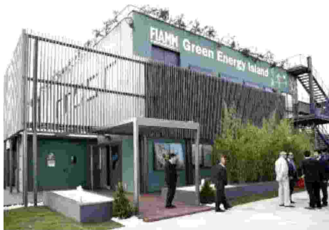
L'isola energetica realizzata da Fiamm ad Almisano
