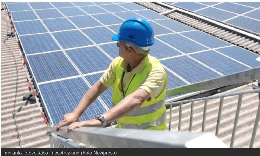
Impianto fotovoltaico in costruzione (Foto Newpress)
