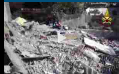
Crolla una palazzina a Torre Annunziata: 8 dispersi
