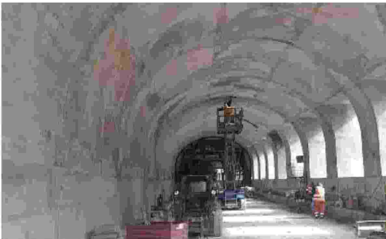
I lavori sulla statale 'Contessa' che collega l'eugubino alla provincia di Pesaro
