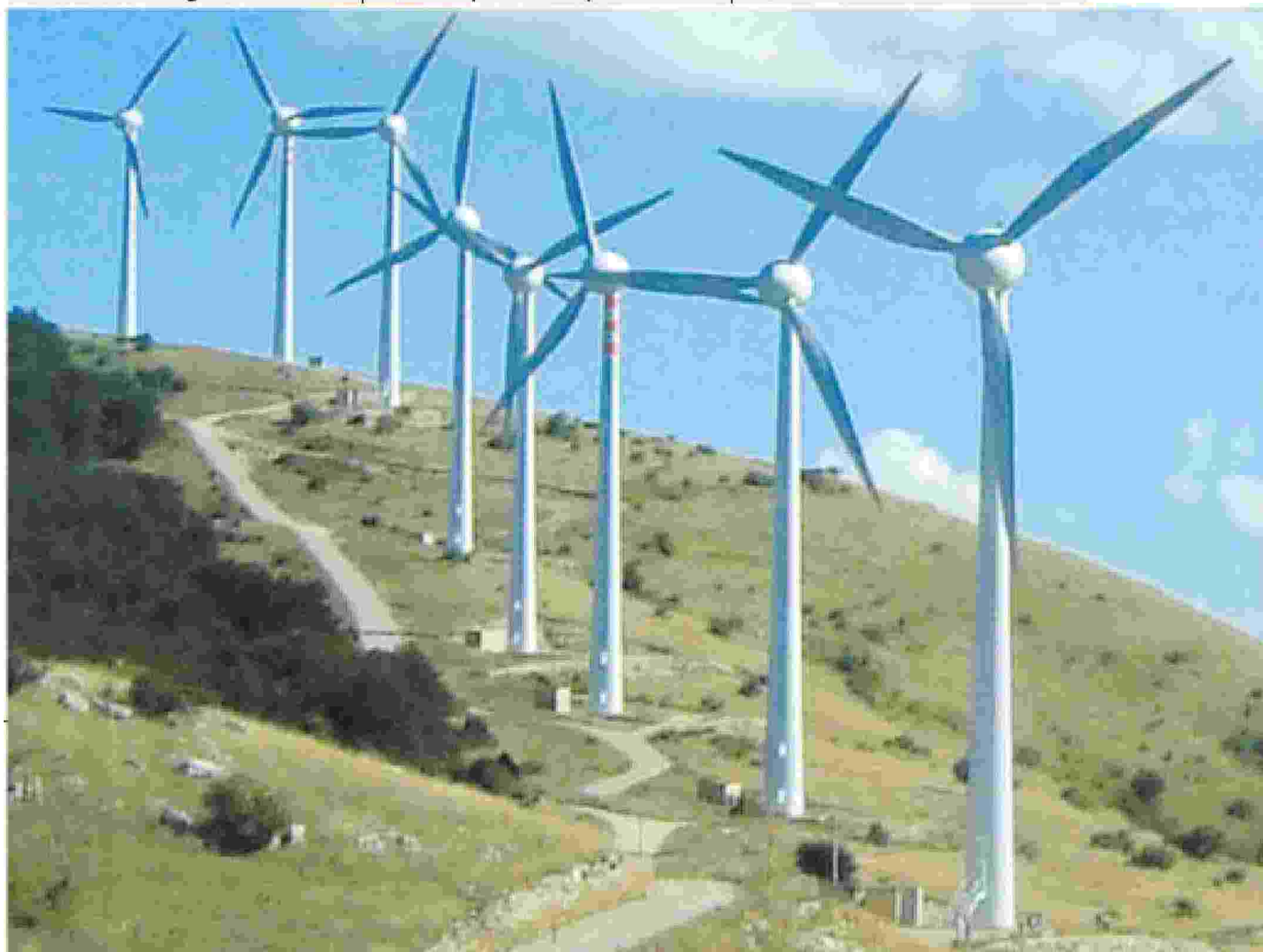
Pale eoliche per lo sfruttamento dell'energia derivante dal vento
