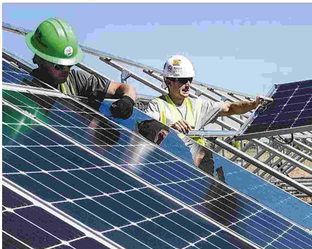
Installazione di pannelli solari. Foto Archivio LegaCoop
